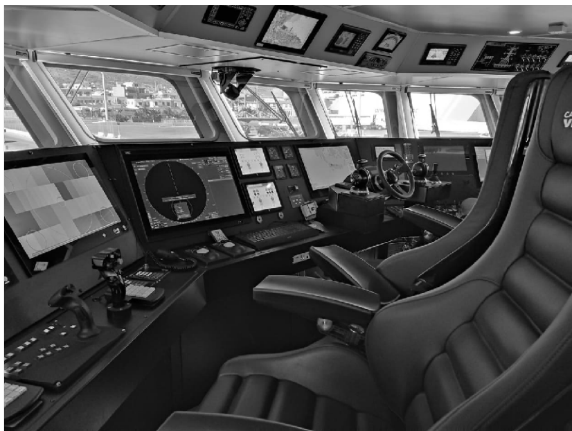
Εξοπλισμός επιτήρησης στη γέφυρα του ΛΣ-920 (justice4pylos.org)
